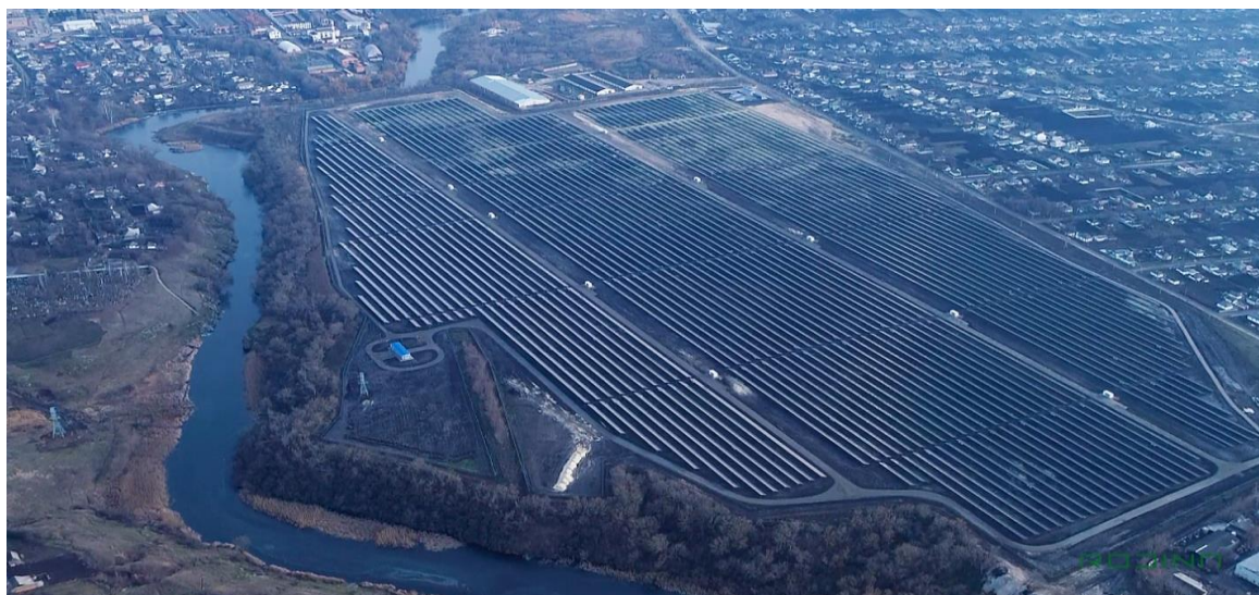
Сонячна електростанція м. Кам'янка, Черкаська область
