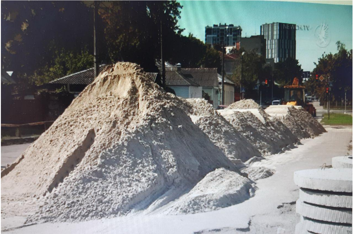
Рис. 4.4.4. Будівництво централізованої каналізації по вул. Фіксея та по вул. Київська від вул. Гонча до вул. Північна в м. Чернігів
