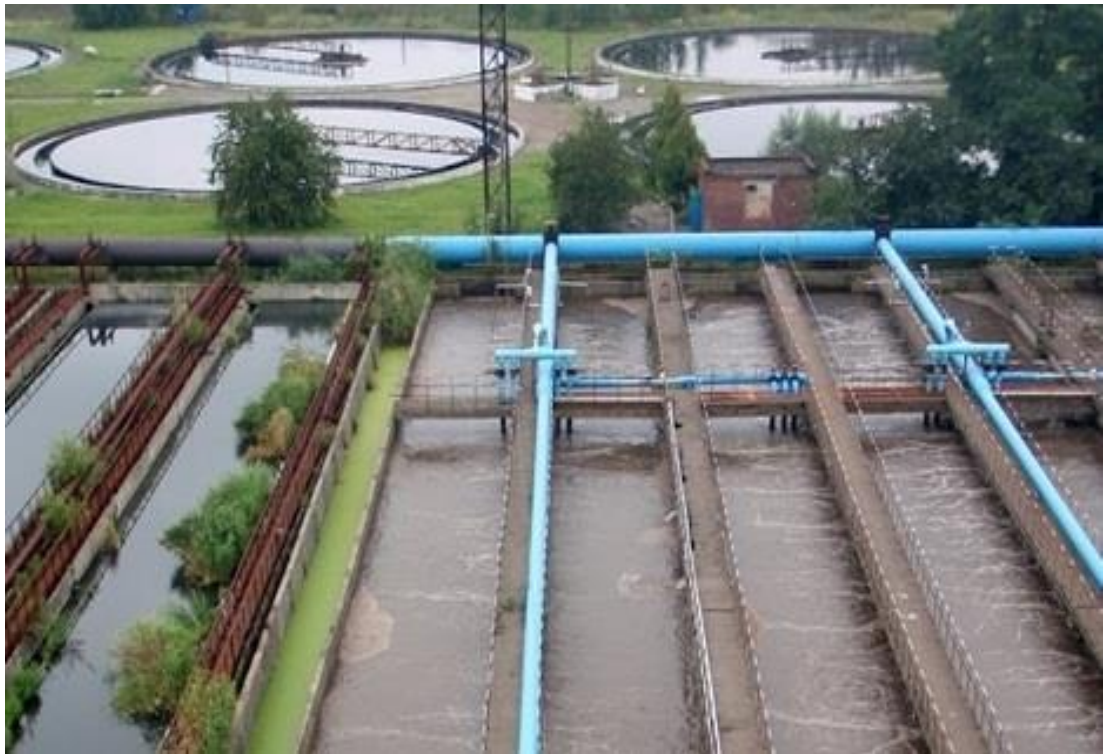
Рис. 4.3. Очисні споруди ЛМКП «Львівводоканал»
