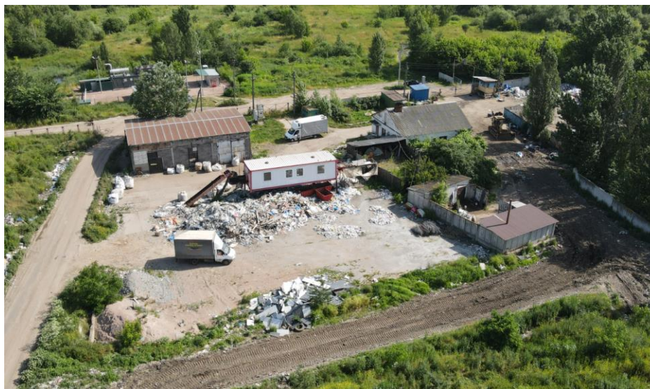
Фото 8.1. Роботи на полігоні ТПВ, м. Житомир
