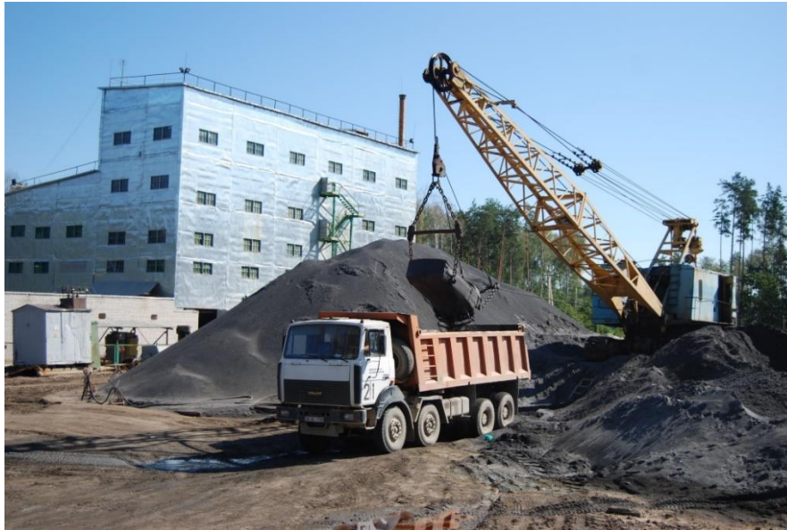
Фото 7.1.1. Збагачувальна фабрика Іршанського ГЗК
