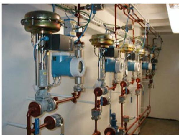
Рисунок 6.28. Вимірювально-дозувальна система з пневматичними клапанами
