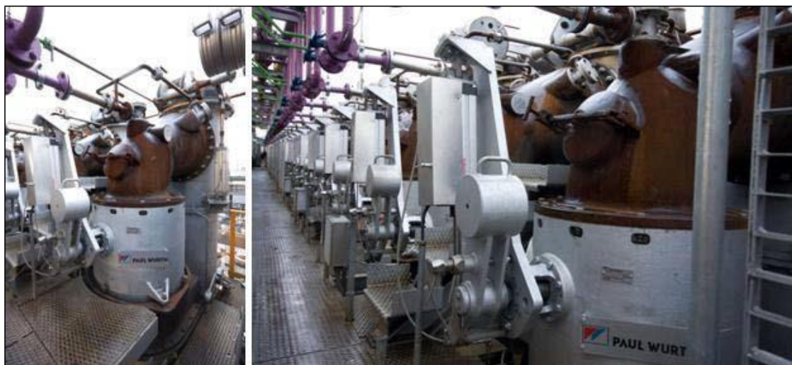
Рис. 11.5. Клапани SOPRECO модель 2 на батареї коксових печей
