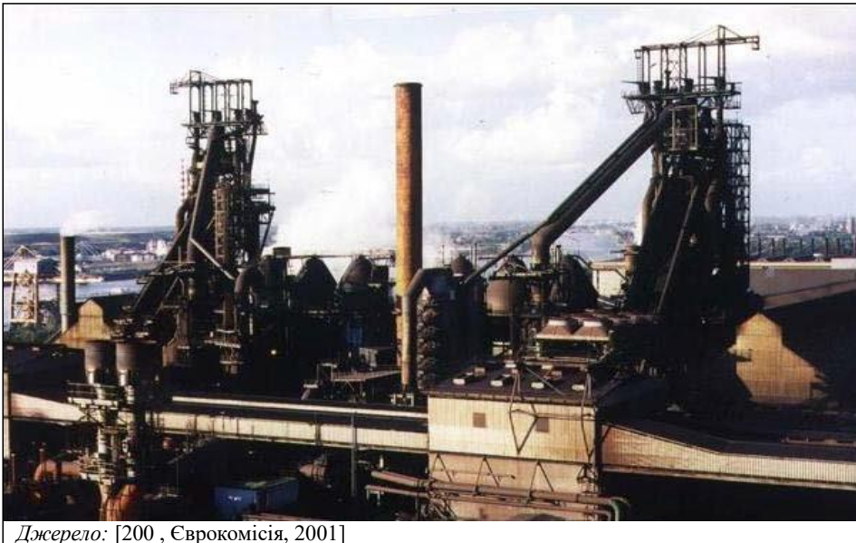
Рис. 6.1. Загальний вид двох доменних печей із трьома повітрянагрівачами для кожної та димовою трубою для відхідних газів із повітрянагрівачів
