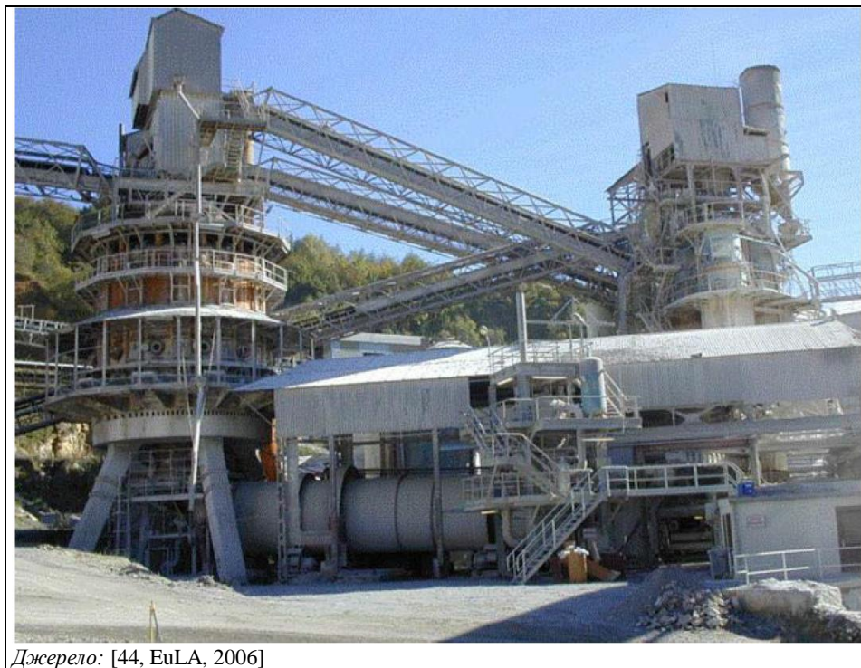
Рисунок 2.34. Приклад обертової печі з підгрівачем
