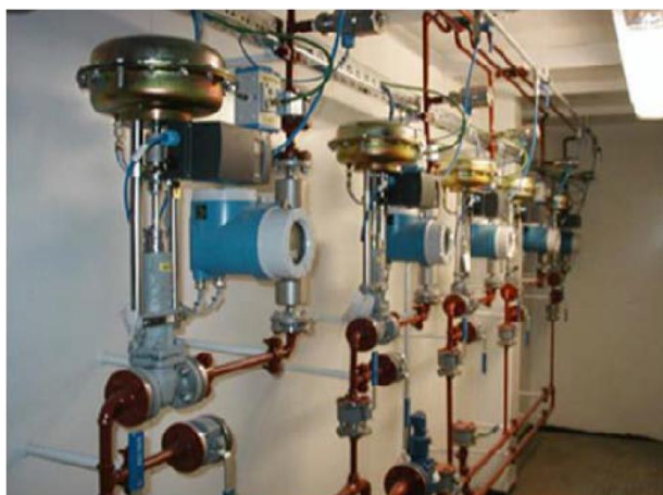
Рисунок 6.28. Вимірювально-дозувальна система з пневматичними клапанами
