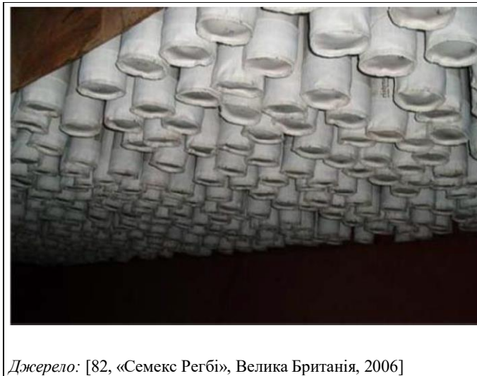
Рисунок 1.60. Приклад рукавного фільтра та фільтрувального матеріалу, що використовується на цементному заводі у Великій Британії
