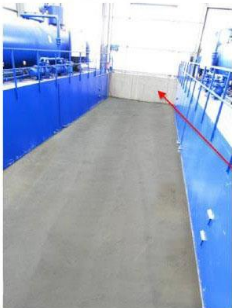
Рисунок 15.21: Приклади конструкцій для систем утримування для процесу
